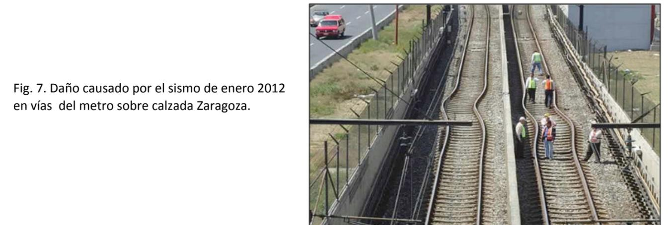
Fig. 7. Daño causado por el sismo de enero 2012 en vías del metro sobre calzada Zaragoza.
